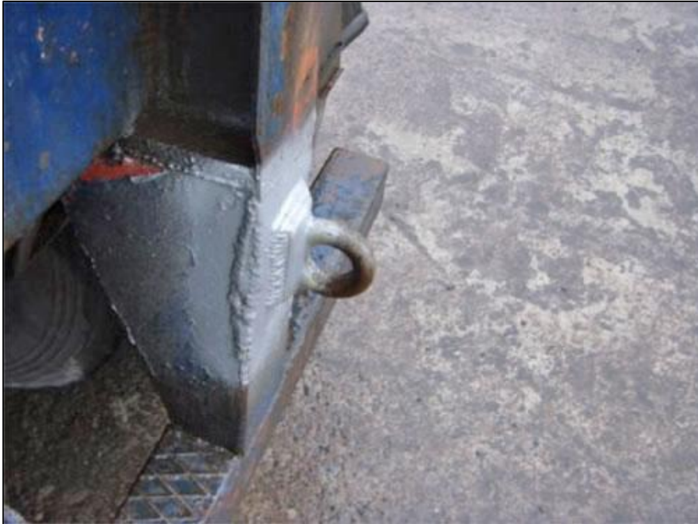
Figura 11 – “Olhal” fixado em uma estrutura
